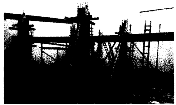
MODULO C - ENCOFRADO DE COLUMNAS
